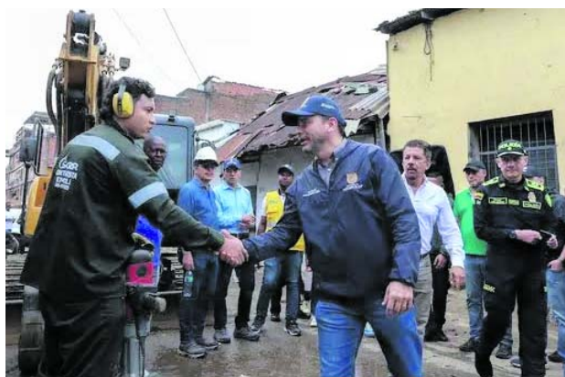
Demoliciones en el centro de Cali comienzan dentro del Plan Cristo Rey y la intervención de Ciudad Paraíso.
