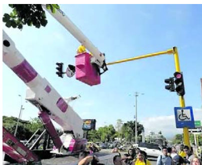
EnRuta administrará los semáforos de Cali y adelantará trabajos de mantenimiento en cerca de 500 intersecciones.
