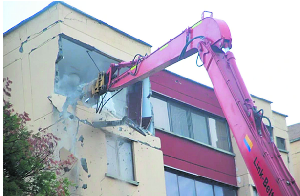
Cali prepara la demolición de 60 edificaciones afectadas por el terremoto del 10 de agosto.
