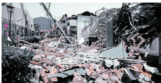
Las demoliciones de edificaciones afectadas ya comenzaron en el centro de Roldanillo, como parte de las acciones posteriores al terremoto del 10 de agosto.
