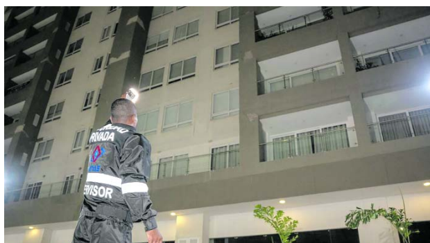
Evaluación de estructuras afectadas por el terremoto continúa en Cali tras el sismo del 10 de agosto. Foto: Alcaldía de Cali
