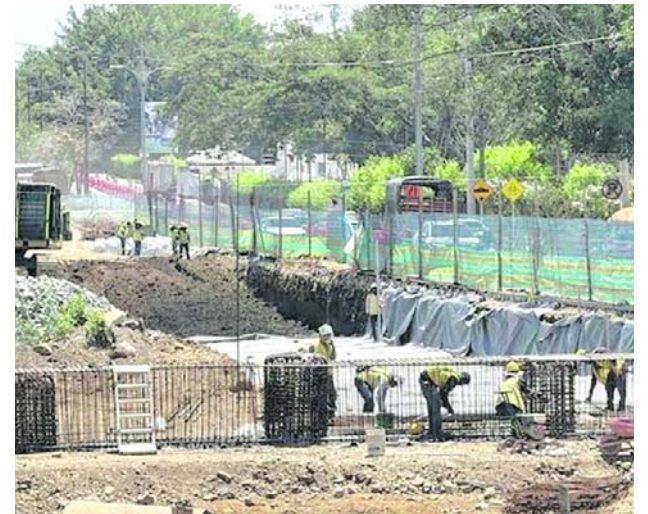
Segunda calzada de la Avenida Cañasgordas supera el 65% de avance.
