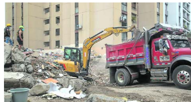
Viviendas aseguradas afectadas por el sismo en Cali pueden iniciar la reclamación directamente con su aseguradora.
