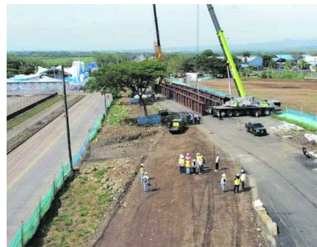
Ya se instalaron las vigas del nuevo puente en Pance.
