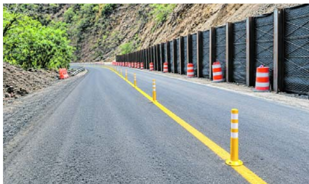
Municipio de Dagua. (PR 69+400) Sector La Yolomba
