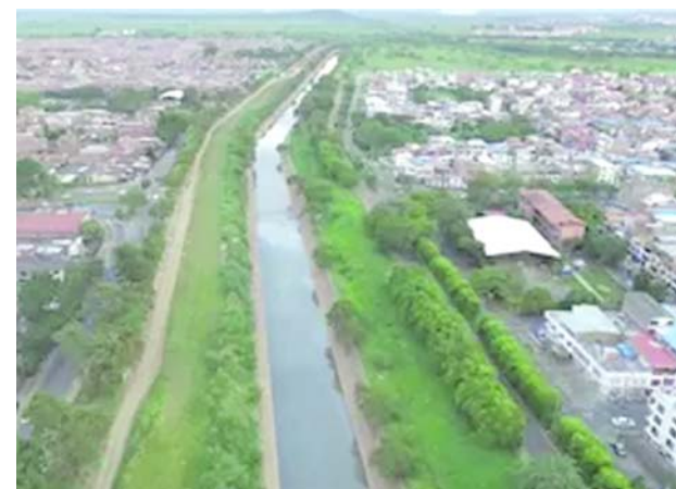
El Jarillón del río Cauca será revisado para conocer su estado después del sismo.
