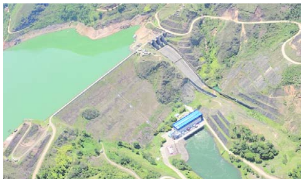
La represa de Salvajina pasó los exámenes técnicos luego del terremoto.
