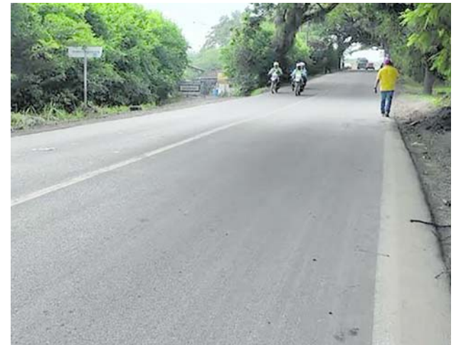
El puente Omar Torrijos, entre Roldanillo y Zarzal, mantiene restricciones de tránsito mientras avanzan las inspecciones de la infraestructura vial.
