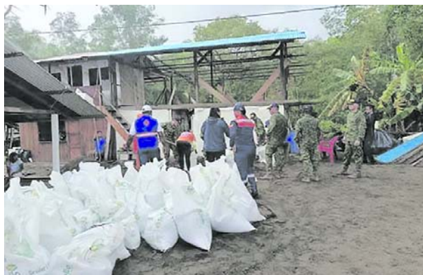
Habitantes de Nabugá participan en la instalación de muros temporales con sacos de arena.
