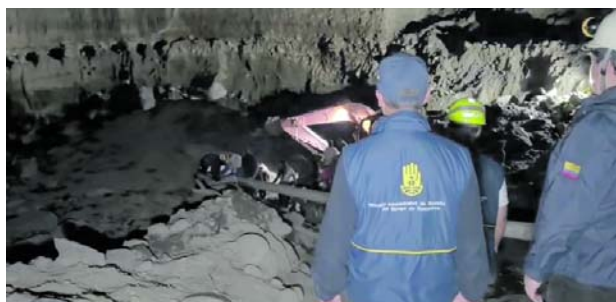
Equipos de emergencia y habitantes trabajaron durante la noche para remover tierra.
