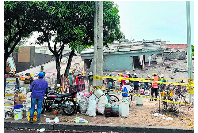
La Alcaldía de Santiago de Cali definió una ruta para reportar y evaluar las afectaciones en viviendas tras el sismo.
