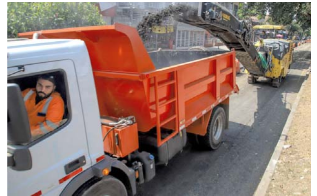
Recuperación de la malla vial en Cali avanza con 16 cuadrillas en distintos sectores
