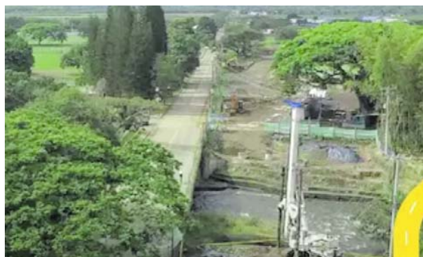
La movilidad en la avenida Cañasgordas se mantendrá por una sola calzada en doble sentido mientras avanzan las obras del puente sobre el río Pance.
