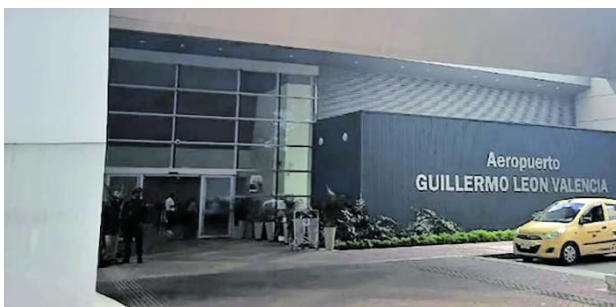
El Aeropuerto Guillermo León Valencia realiza un monitoreo permanente.
