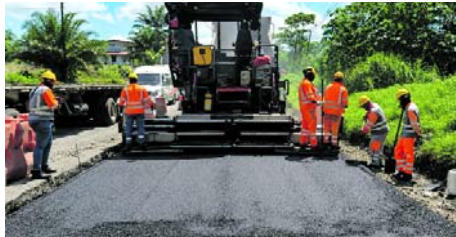
Los trabajos en la vía a Buenaventura avanzan a buen ritmo.
