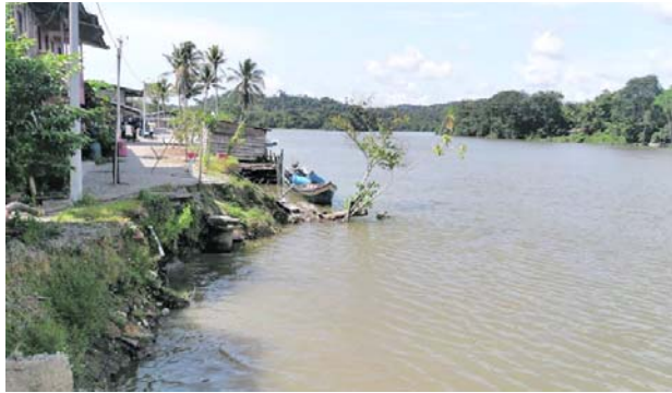
La Defensoría del Pueblo verificó en terreno la erosión que afecta a Veneral del Carmen, en Yurumanguí, mientras la Alcaldía de Buenaventura avanza en los estudios para un muro de contención.
