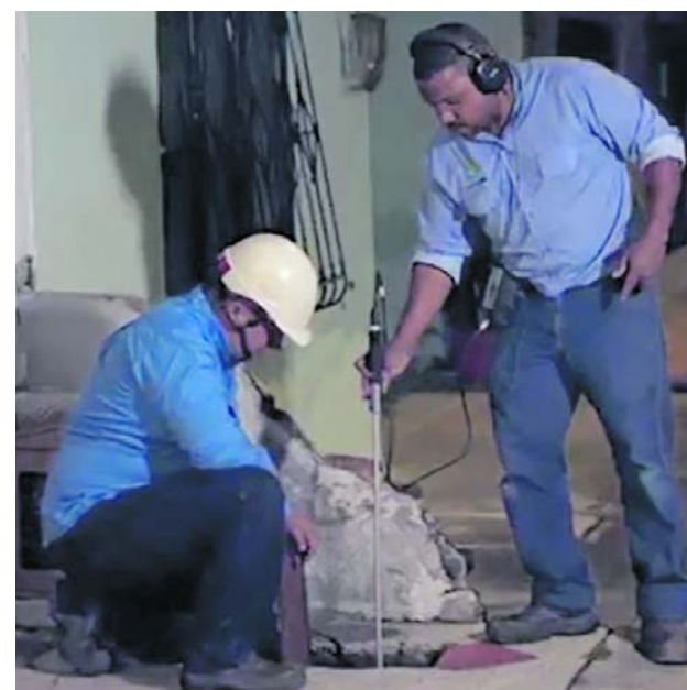
Acuavalle adelanta la revisión a las redes de acueducto para evitar fugas de agua.
