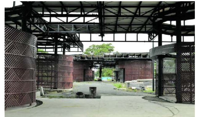
El proyecto Parque Pacífico registra actualmente un avance físico cercano al 85%.
