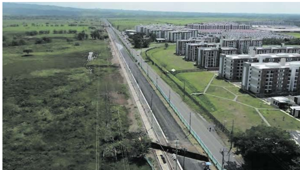
La gobernadora del Valle, Dilian Francisca Toro, realizó un sobrevuelo a las obras de la Avenida Cañasgordas.
