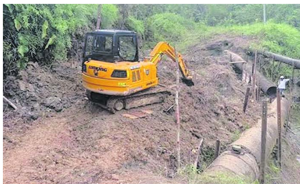
Maquinaria pesada y operarios trabajan en el sector de El Venado para llegar al punto de la emergencia y reparar la tubería que abastece de agua a Buenaventura.
