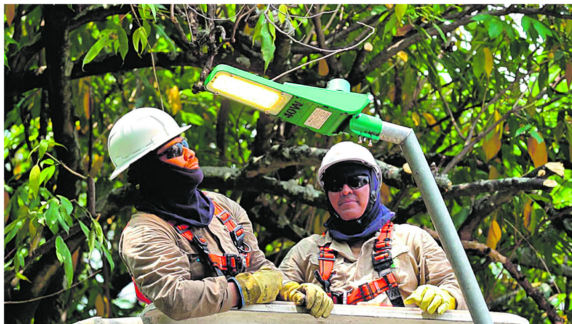
El proyecto contempla la modernización integral del sistema de alumbrado público de Cali mediante la instalación de 101.037 luminarias LED
