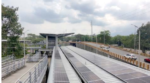
Usuarios del MIO ya cuentan con planta solar y wifi gratuito en la Terminal Simón Bolívar. Foto: Emcali
