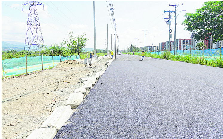
Con el acompañamiento de la comunidad la obra marca la transformación para este sector del sur del Valle.
