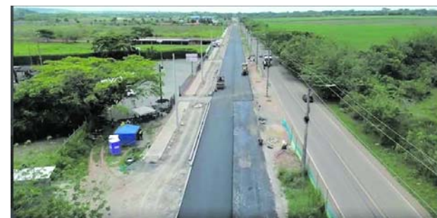
Obras de la Avenida Cañasgordas superan el 40% de ejecución. Foto: Gobernación del Valle
