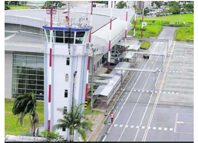
Durante seis horas se realizaron reparaciones de desgastes superficiales en la pista antes de reanudar los vuelos comerciales.
