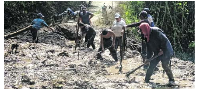
Vías rurales bloqueadas por escombros y material vegetal mantienen incomunicadas a comunidades campesinas en zona alta de Pradera.
