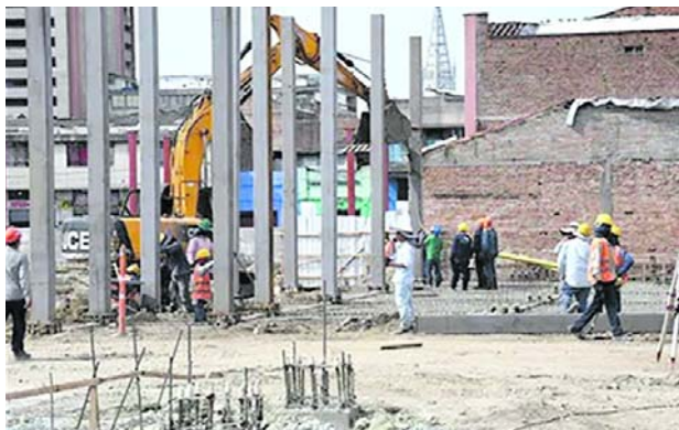
Avanzan las obras de construcción de la nueva Plaza de Mercado de Buenaventura.
