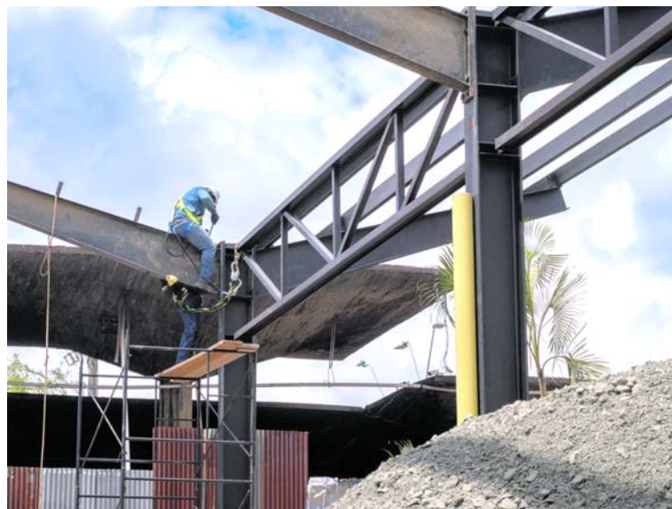
Obras de la Plaza de Mercado de Siloé avanzan en fase final tras incendio ocurrido en 2022.
