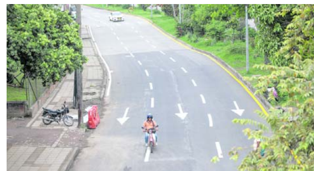
Dispositivos viales fueron instalados temporalmente en las obras de prolongación de la avenida Ciudad de Cali.
