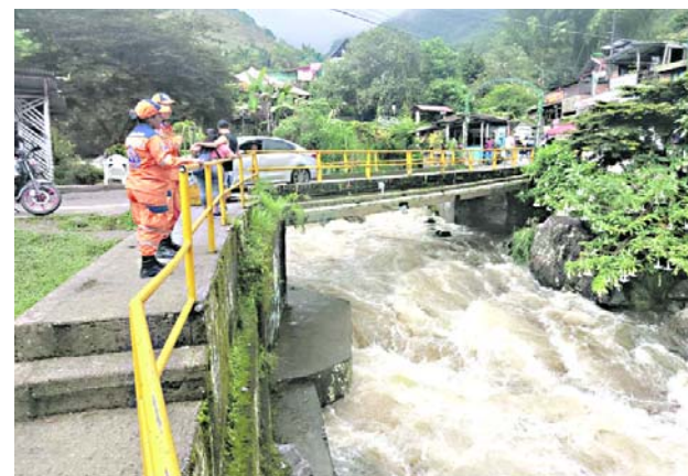
Gestión del Riesgo monitorea zonas como Pance y Villa Carmelo tras fuertes lluvias en Cali.
