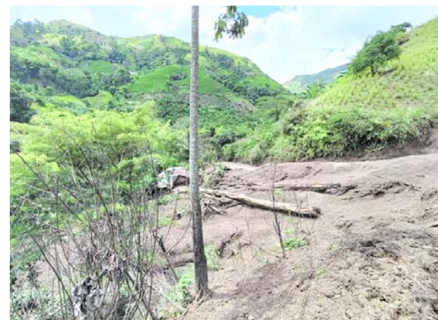
Viviendas destruidas y vías afectadas en la vereda Santa Ana, zona rural de Suárez, tras la avalancha provocada por las intensas lluvias.
