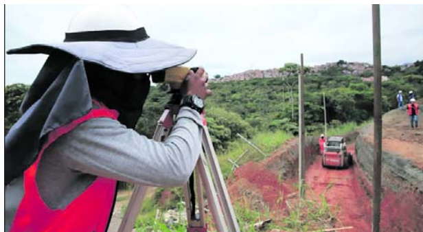
Foto: Alcaldía de Cali La ampliación de la carrera 80 en Cali avanza con construcción de glorieta y muros de contención.
