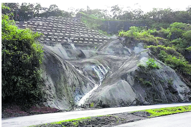
La Nación y el Departamento del Valle dieron al servicio obras de estabilización de la montaña en puntos clave de la vía.
