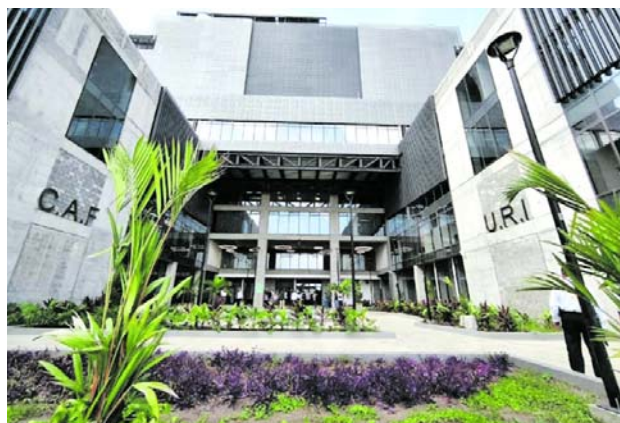
El búnker de la Fiscalía en Cali mejora la atención judicial y renueva el centro urbano.
