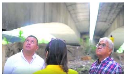
Profesionales de la ingeniería inspeccionaron el nuevo puente de Juanchito.
