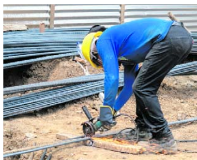
Quirófanos en el Hospital Carlos Holmes Trujillo mejorarán la atención médica en el oriente de Cali.
