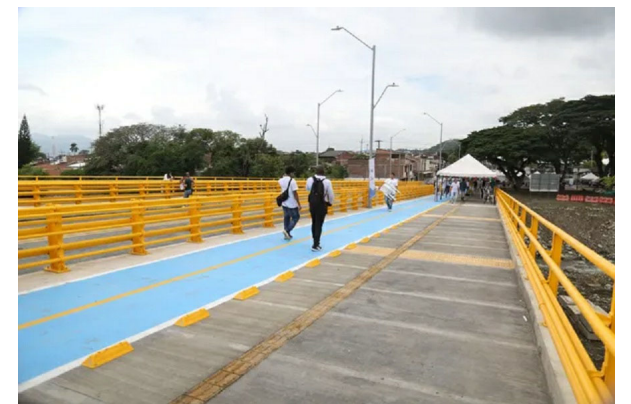
El moderno puente sobre la Carrera Primera de Buga impulsará el desarrollo de un sector importante de Buga.
