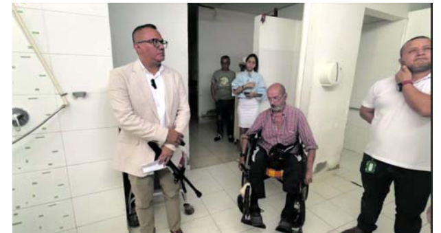
Filtraciones y humedades en el Hospital Geriátrico San Miguel ponen en riesgo la salud de los residentes
